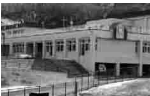
避難施設が併設された洞爺湖温泉小学校
