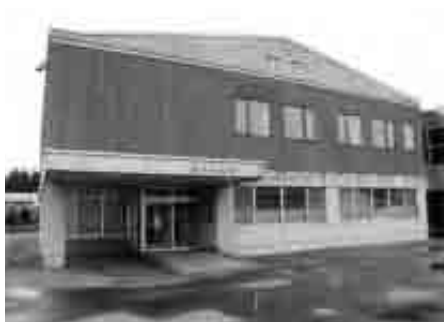
現在使われていない洞爺診療所の建物
