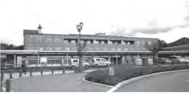
洞爺湖町の庁舎。外壁に標高を書く事が検討される。
