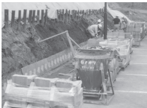
擁壁補修工事
