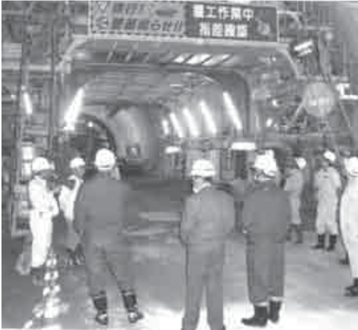
青葉トンネル
