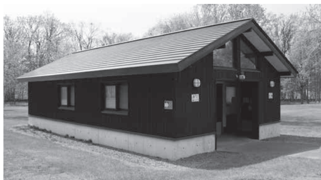
▼照明をLED化し、夜間も安心して使えるようになったトイレ棟
